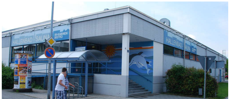
Das bestehende Mühldorfer Hallenbad in der Leopoldstraße
