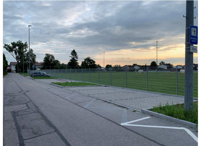
Die neu errichteten Parkplätze an der Auerstraße in Mößling entlang des Sportplatzes
