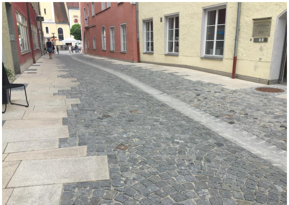
Ledererstraße nach der Sanierung
