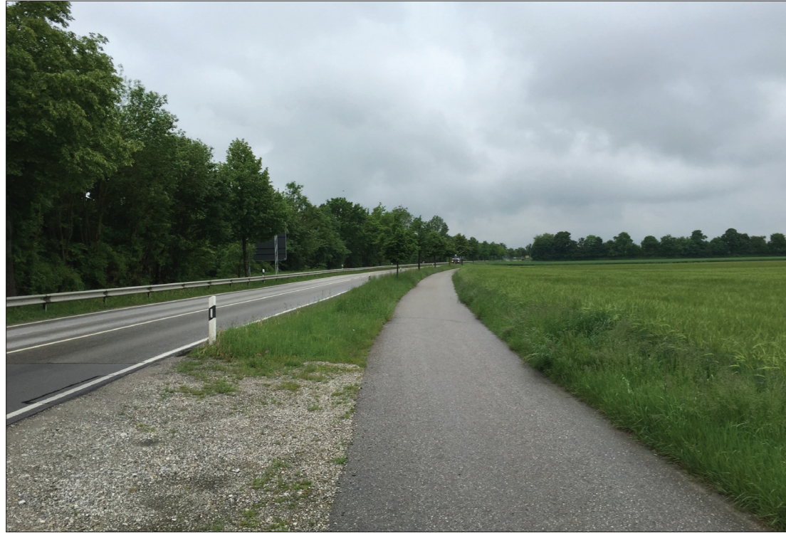
Nordtangente, westlich des Knotens mit der Kreisstraße MÜ 6, Richtung Westen
