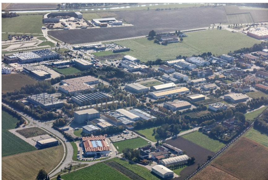
Gewerbegebiete im Mühldorfer Nordosten, Foto: Klaus Leidorf
