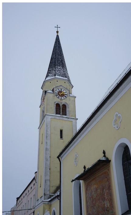
Derzeit wird die Innenschale der Frauenkirche saniert.
