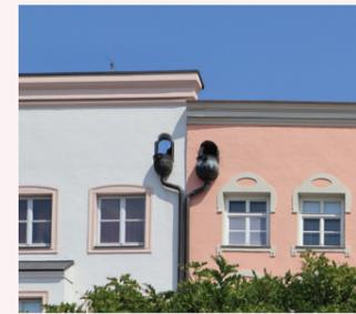
Typisch ist eine Dachentwässerung über Wassersammelkästen aus Kupfer- oder Zinkblech.
