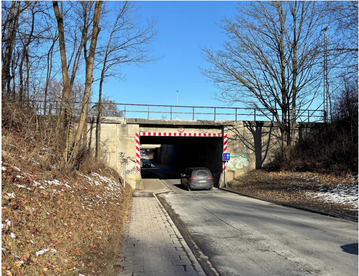
Abbildung. 3: Bahnunterführung Kapellenstraße in Mühldorf (Januar 2026)
